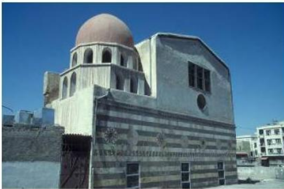
المدرسة الشاذبكية قبل الترميم
